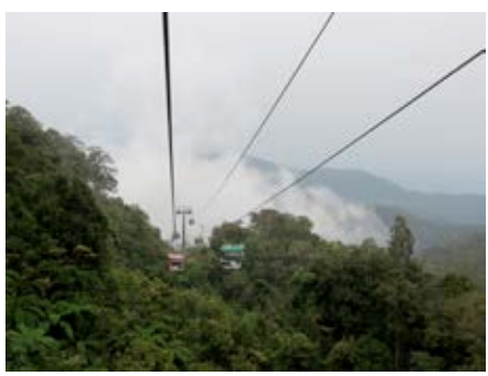
■ สนง.เข้าไฟฟ้า ชั้น-ลง ยอกเขาเกินกั๊ด
